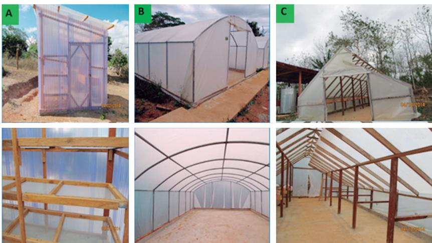
Figura 19. Técnicas de secado natural por medio de la utilización de casetas de secado y zaranda de fondo de alambre (A), túnel plástico sobre patio de secado (B) y (C) caseta plástica con zarandas de alambre con abertura en la parte superior del techo para permitir la salida de aire caliente y sirviendo para la regulación de temperatura. Fotografías Néstor Bonilla Bird.
