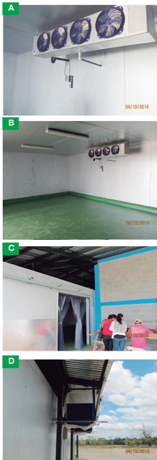
Figura 53. Cuarto frío para la conservación de semillas de granos básicos, en Nueva Guinea-RAAS. A. Unidades del deshumidificador. B. Vista de piso aislante y cuarto completamente sellado. C. Entrada a cuarto frío con aislantes flexibles para detener el intercambio de temperaturas con el exterior. D. Unidades externas de enfriamiento. Fotografías Néstor Bonilla Bird.
